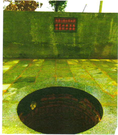
毛里山组公共水源施工后
