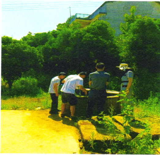
毛里山组公共水源施工前
