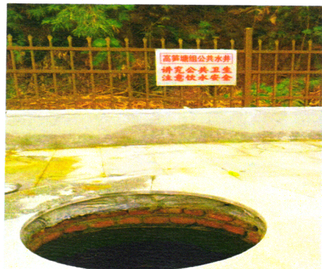
高笋塘组公共水源施工后
