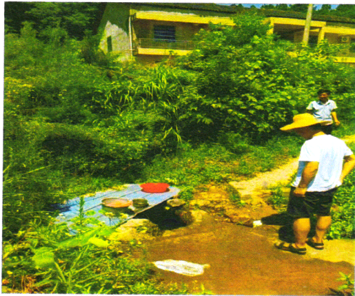
戈子塘组公共水源施工前
