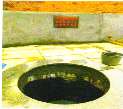
戈子塘组公共水源施工后
